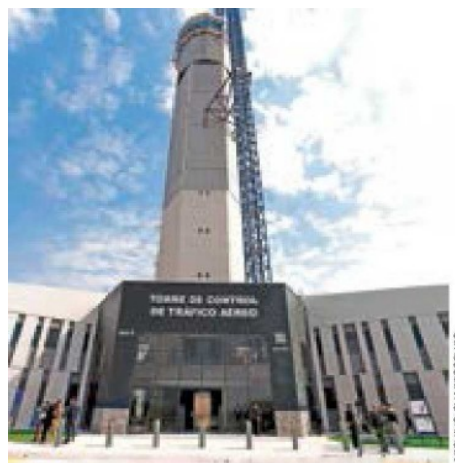
PLAN. El rediseño del espacio aéreo se realizó para que el aeropuerto de Santa Lucía opere; la torre de control tiene un avance de más de 50%.
