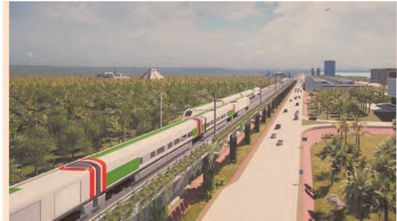
El tramo Cancún-Ciudad del Carmen del Tren Maya se ejecutará a través de un viaducto elevado, para minimizar el impacto urbano de las obras. FOTO: ESPECIAL
