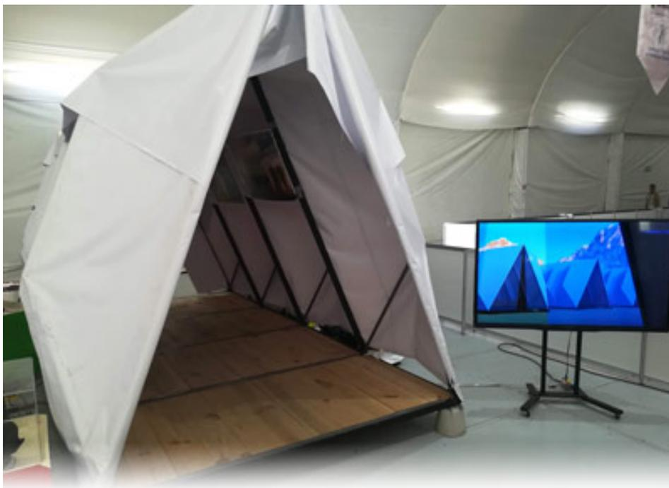
**El diseño de Viv.E permite que el aire circule a través de su interior para disminuir la temperatura en condiciones de calor y el material usado como techo y paredes permite conservar la temperatura en condiciones de frío.**
