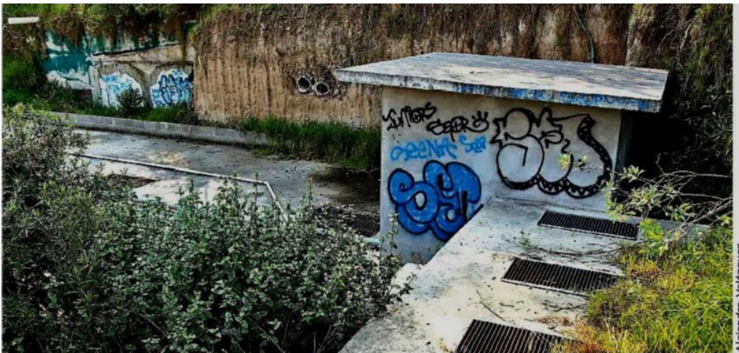
■ El Municipio indicó que la planta se encuentra en obra civil, con equipamiento parcial.
