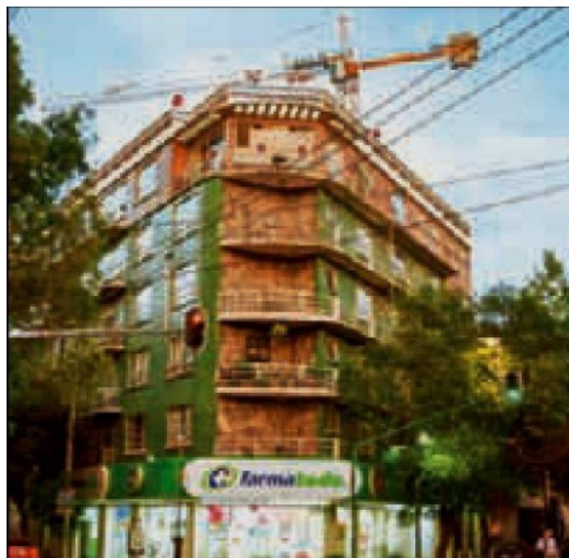
El edificio Sevilla 710 presenta daños.
