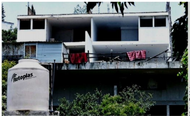
■ En el sitio se pretende construir un edificio con densidad mayor a la permitida.
