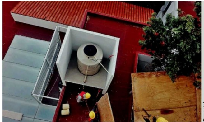
■ Los damnificados culpan a Coyoacán de no apoyarlos.
