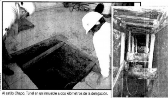
Al estilo Chapo. Túnel en un inmueble a dos kilómetros de la delegación.
