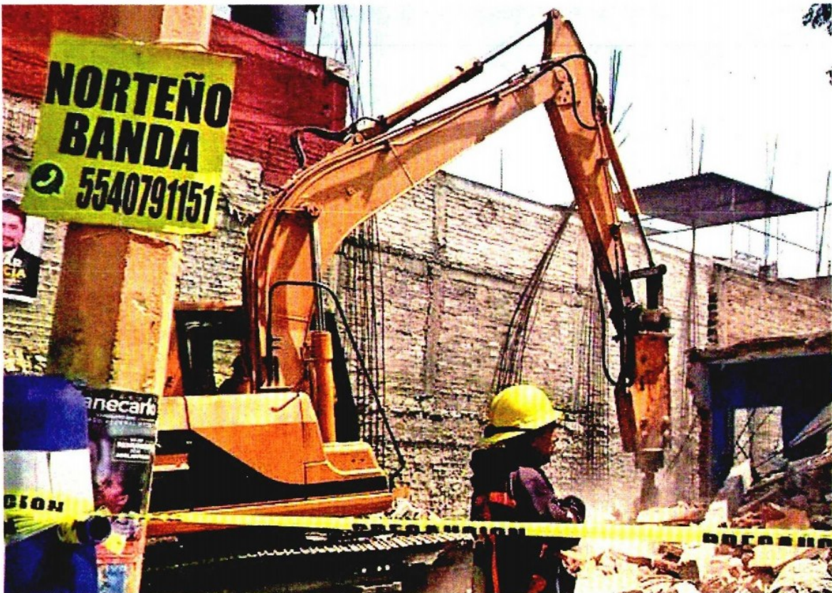
La Secretaría de Obras y Servicios capitalina ha concluido exitosamente la demolición de varios edificios dañados por el sismo del año pasado.
