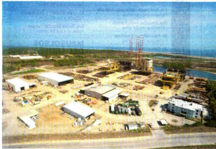
Diversos rezagos en las obras de urbanización de la Refinería Dos Bocas orillan a Pemex a sustituir a la empresa Hostotipaquillo.
