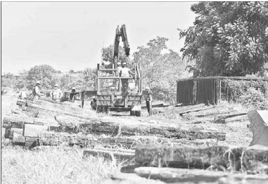
▲ Trabajadores de Grupo Carso quitan vías férreas para la colocación de durmientes de concreto, que resisten velocidades hasta de 160 kilómetros por hora, como parte de las obras del Tren Maya en Campeche. Foto Lorenzo Chim
