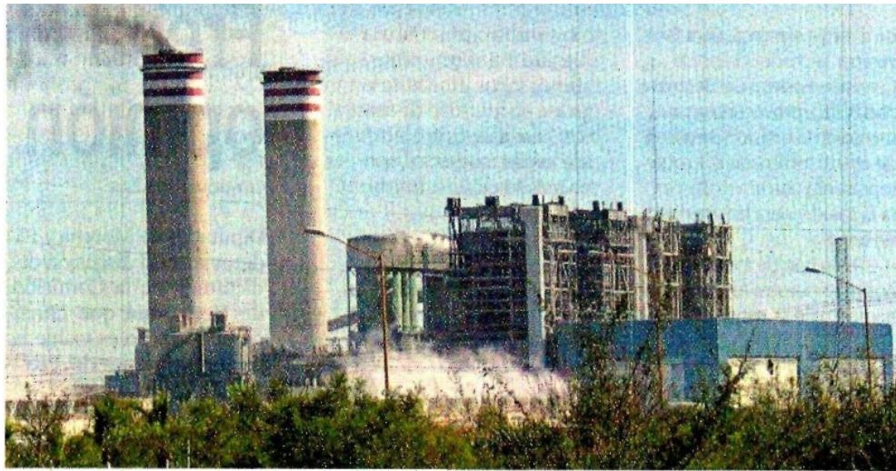
■ Planta carboeléctrica de la CFE ubicada en el municipio de Nava, Coahuila.
