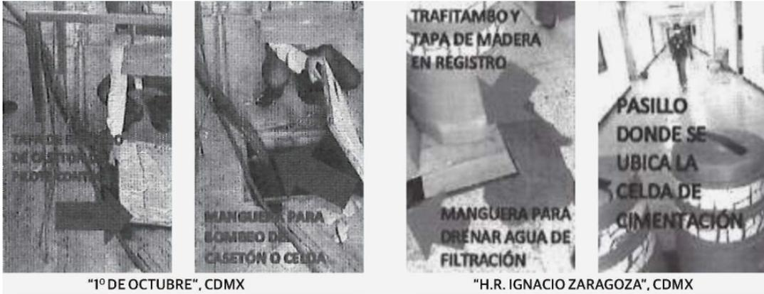
EN PILOTES DE CONTROL, se observa cimentación de los edificios con celdas abiertas.
