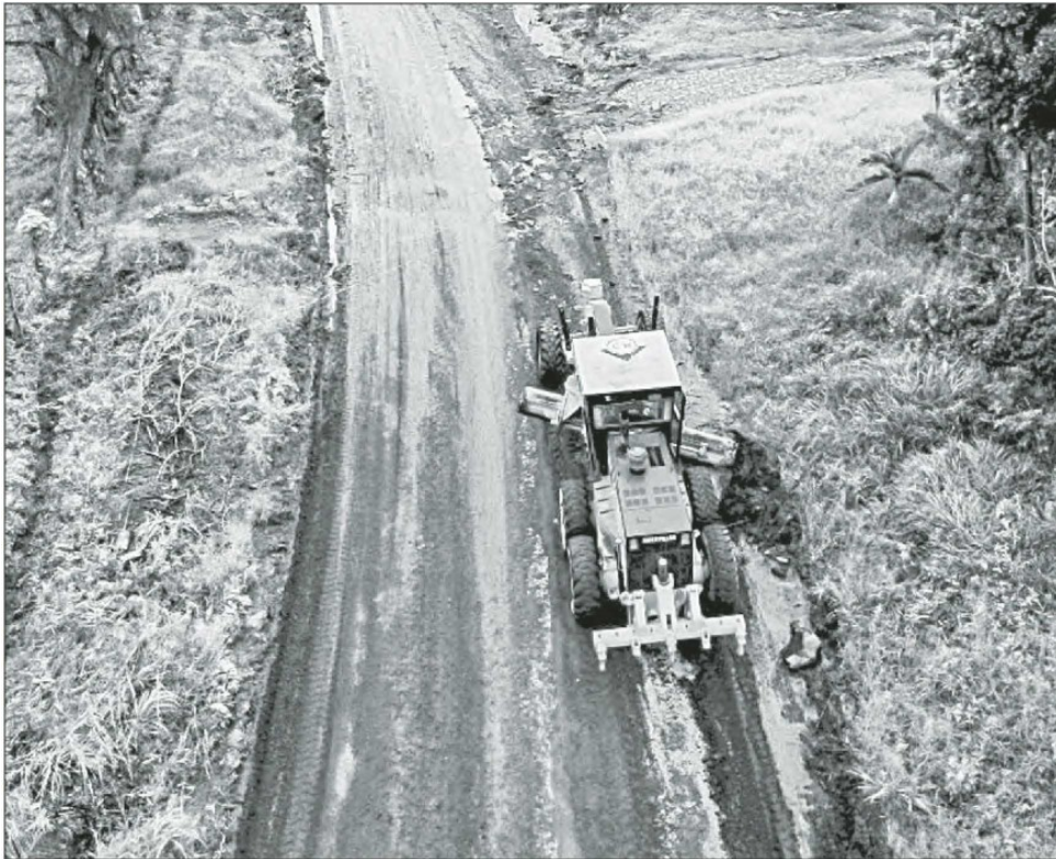
Los trabajos de reconstrucción continúan en el tramo de la carretera Isla-Santiago Tuxtla, en Veracruz, dañada por las anegaciones del mes pasado. Foto Facebook Fercho Díaz
