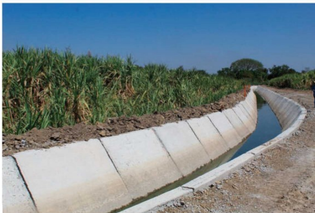
El proyecto incluye revestimiento de canales que antes eran de tierra; bombeo y conducción del agua hasta aplicar el riego por goteo al terreno de caña que antes se inundaba completamente
