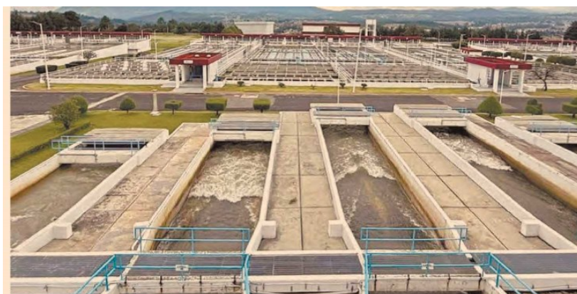
El Sistema Cutzamala se conforma de tres presas: Valle de Bravo, Villa Victoria y El Bosque. FOTO: ESPECIAL
