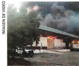
CIERRE. Por la tarde, las instalaciones de Alimentación para el Bienestar comenzaron a arder.
