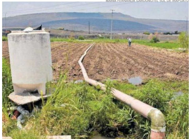
Instalación de riego en el campo del Bajío
