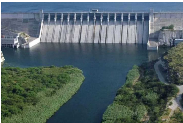
La presa internacional La Amistad, en Coahuila, registra nivel por debajo de la mitad de su capacidad
